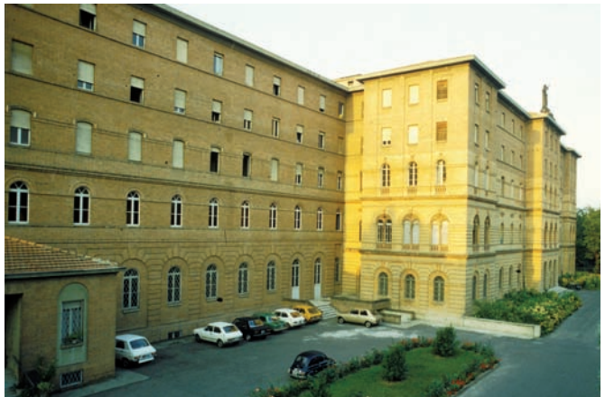
La Maison Mère agrandie et restructurée
