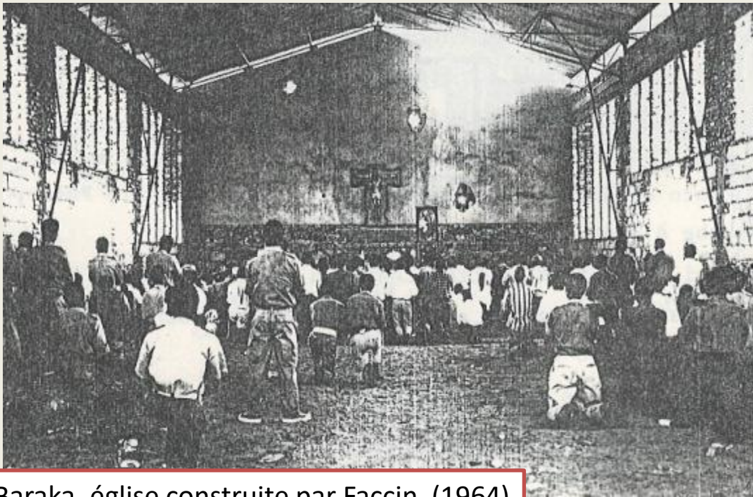
Baraka, église construite par Faccin (1964)
